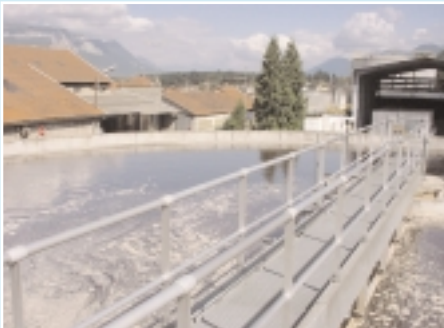
Station d'épuration - Photo : Papeteries de Lancey
